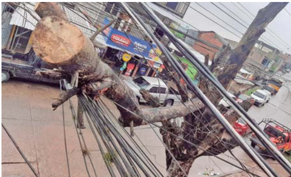
El Cuerpo de Bomberos reportó que en el barrio Reparto por Bajo, un árbol cayó sobre el tendido eléctrico.
