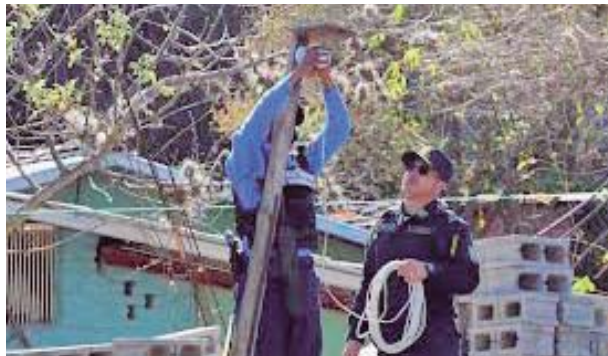
En postes del tendido eléctrico los pandilleros han instalado las cámaras de video para ser alertados de la presencia policial.
