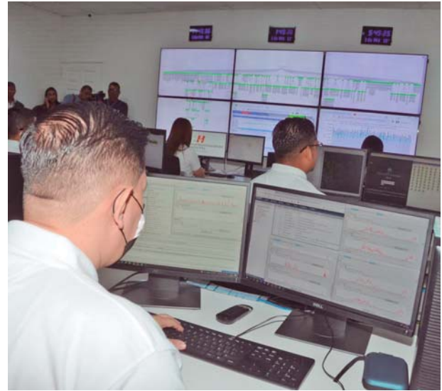
Un centro de monitoreo de red será instalado en Hondutel para detectar de forma inmediata aquellos aspectos urgentes de asistencia técnica.
